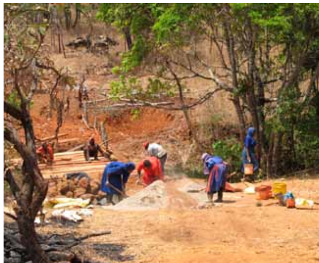
Zement für eine neue Brücke wird gemischt (oben)
